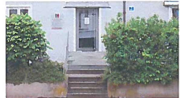
Abbildung 37: Treppenzugang in der Bahnhofstraße
