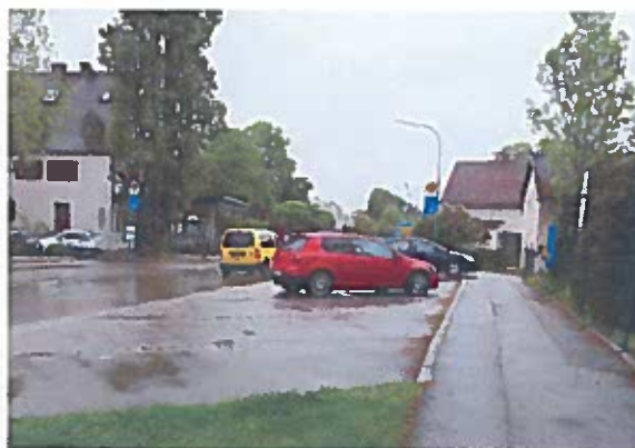
Abbildung 53: Parksituation Jetzendorfer Straße
