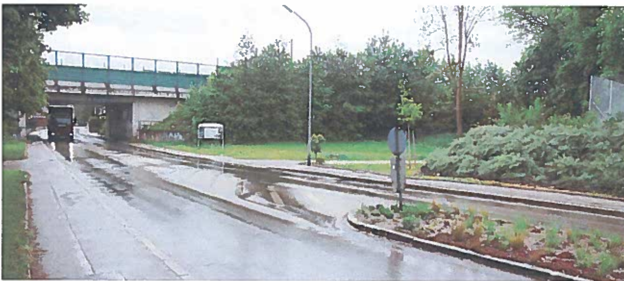
Abbildung 21: Bahnunterführung in der Jetzendorfer Straße
