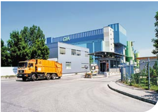
Eingangsbereich Abfallheizkraftwerk Geiselbullach
