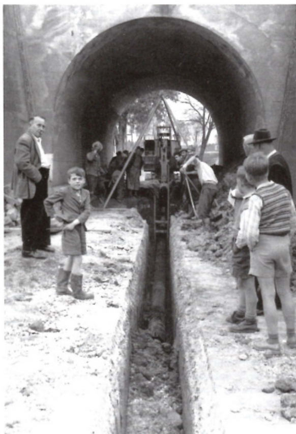
In den Jahren 1957/58 wurden die Rohrleitungen für die Trinkwasserversorgung in Petershausen verlegt. Diese Aufnahme zeigt die Arbeiten unter der alten Bahnunterführung Richtung Jetzendorf.
