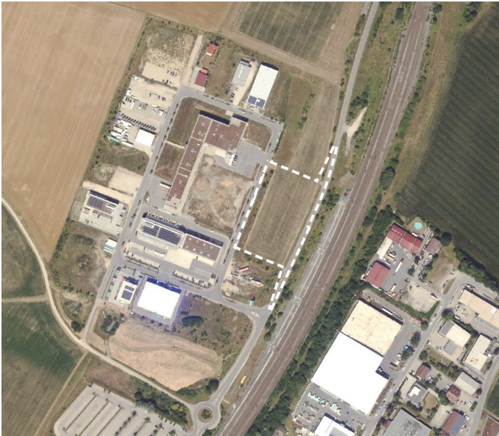
Abb. 3: Lage Geltungsbereich des Bebauungsplans, weiß umrandet, unmaßstäblich, Quelle: BayernAtlas, Bayerisches Staatsministerium der Finanzen und für Heimat, Aufrufdatum 21.04.2023, © Daten: Bayerische Vermessungsverwaltung
