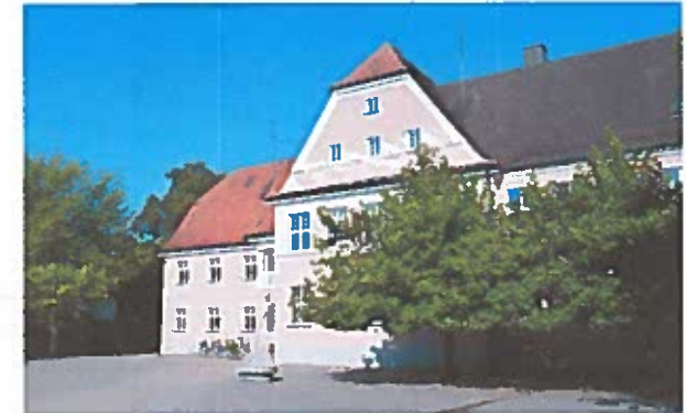
Abb. 24: Altes Schulgebäude und heutiges Rathaus
