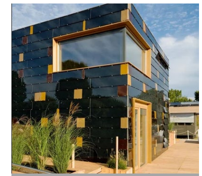
Forschungsprojekt zur PV-Fassade; TU Darmstadt (Solar Decathlon 2009)
