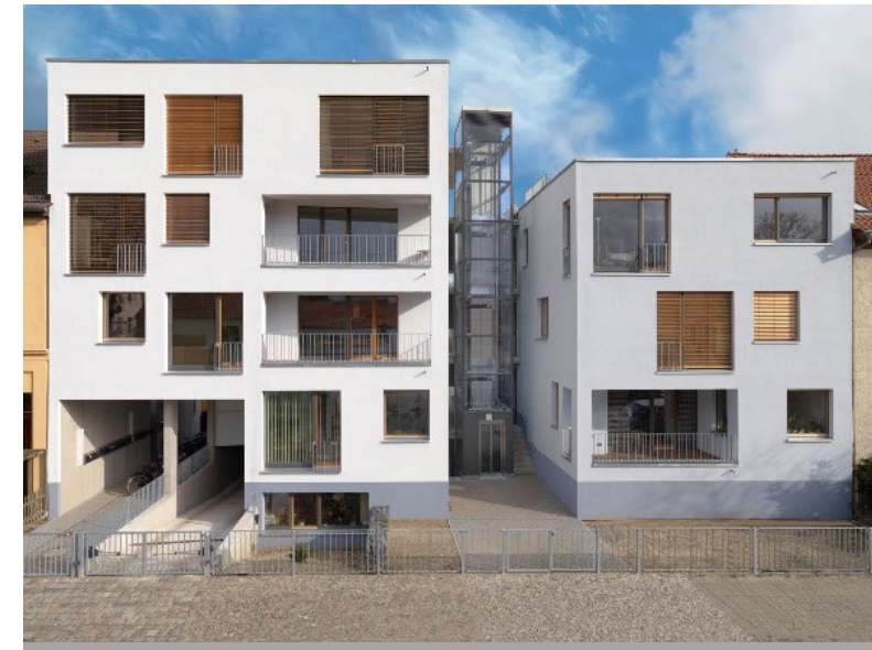
Mehrgeschossiges Wohngebäude in Holzhybridbauweise
