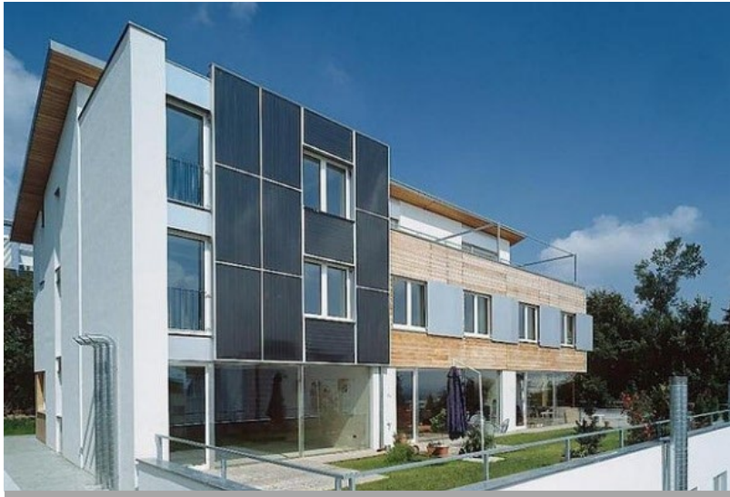
Fassadenintegrierte Kollektoren; Casa Nova, Ulm
