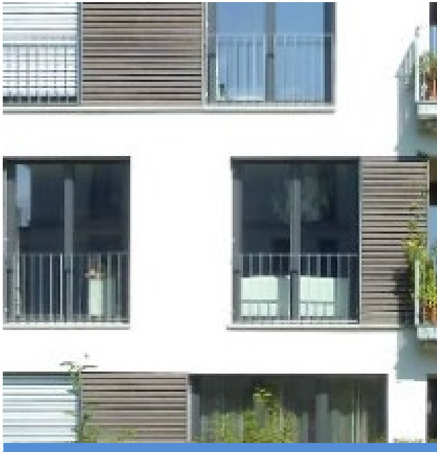
Graue Fenster und Flachstahlgeländer mit dahinter liegendem, satiniertem Glas und Holzintarsien
