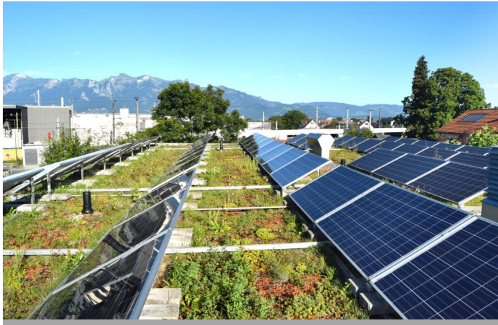
Extensive Dachbegrünung mit aufgeständerter PV-Anlage (Quelle: Energieinstitut Vorarlberg)
