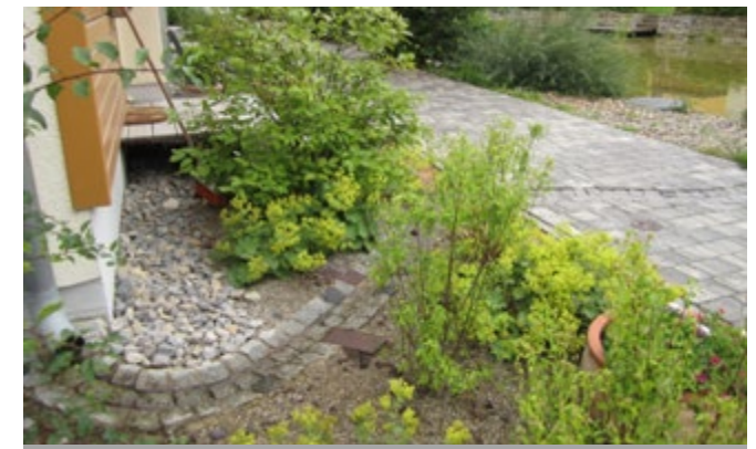
Entwässerung des Dachflächenwassers
