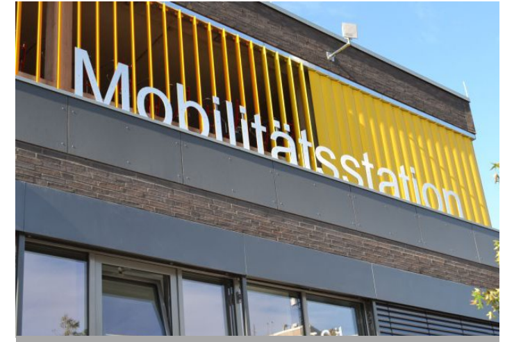
Integrierte Mobilitätsstation in den Kopfbau am Übergang zur Bahn.
