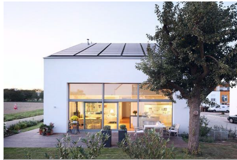
Dachintegrierte Photovoltaik; EE Concept, Darmstadt
