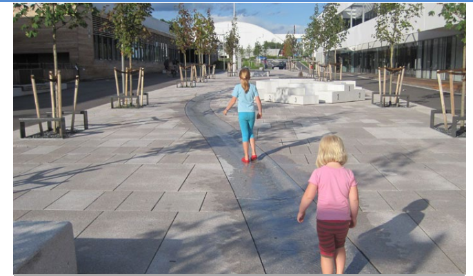
Granitrinne zur Entwässerung
