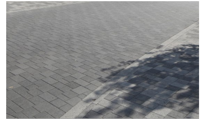
Belagswechsel im Straßenraum
