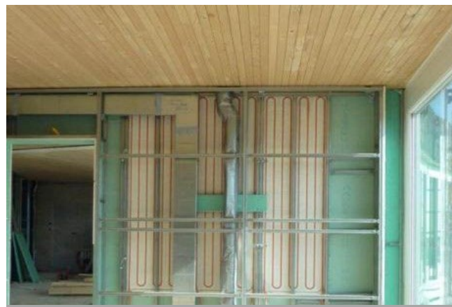
Baustellenfoto Wandheizung; Joachim Eble Architektur
