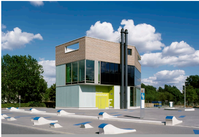
TzW Energiezentrale, Hamburg - bof architekten, Hamburg
