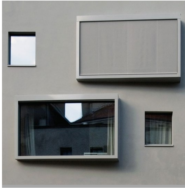
Integration von Sonnenschutz (BCO Architekten)
