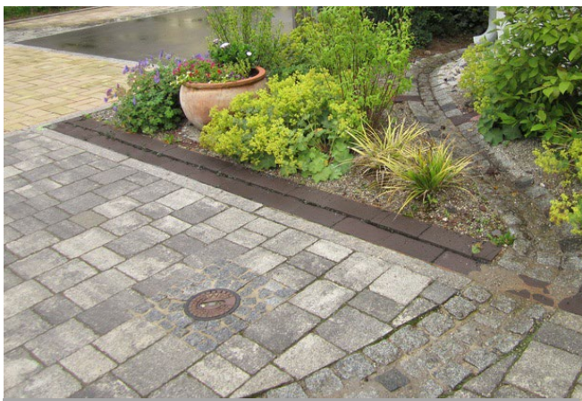
Wasserdurchlässiger Pflasterbelag
