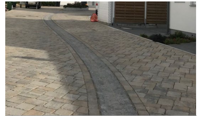
Betonpflaster mit Granitrinne
