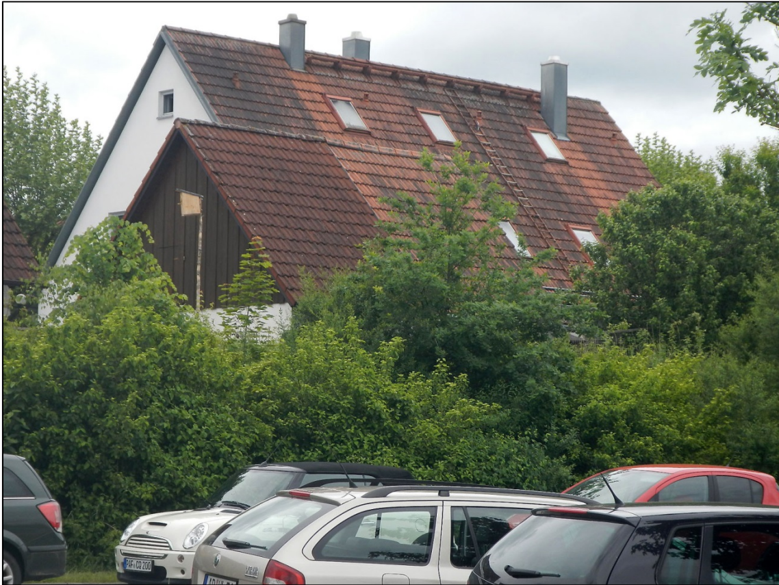
Abbildung 8: Doppelwohnhaus "Mozarttring 14/16" (hier: IO 2, IO 3)
